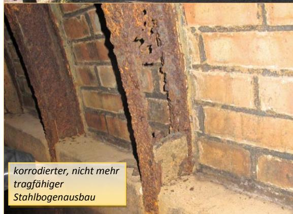
korrodierter, nicht mehr tragfähiger Stahlbogenausbau
